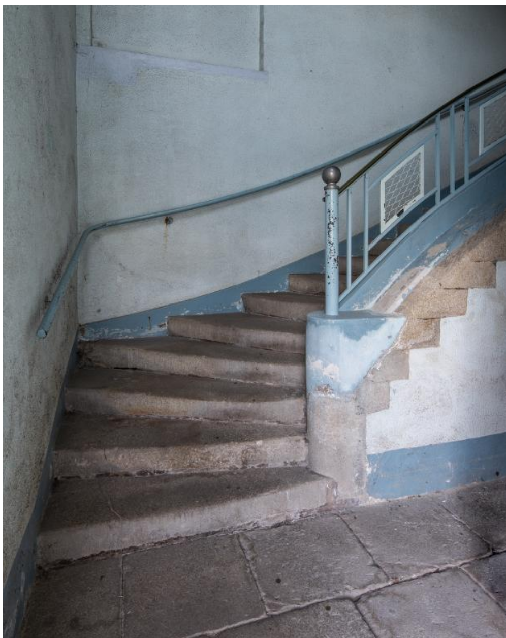
Cage d'escalier en partie réhabilitée vers 1950-1960, dans l'ancien séminaire.
