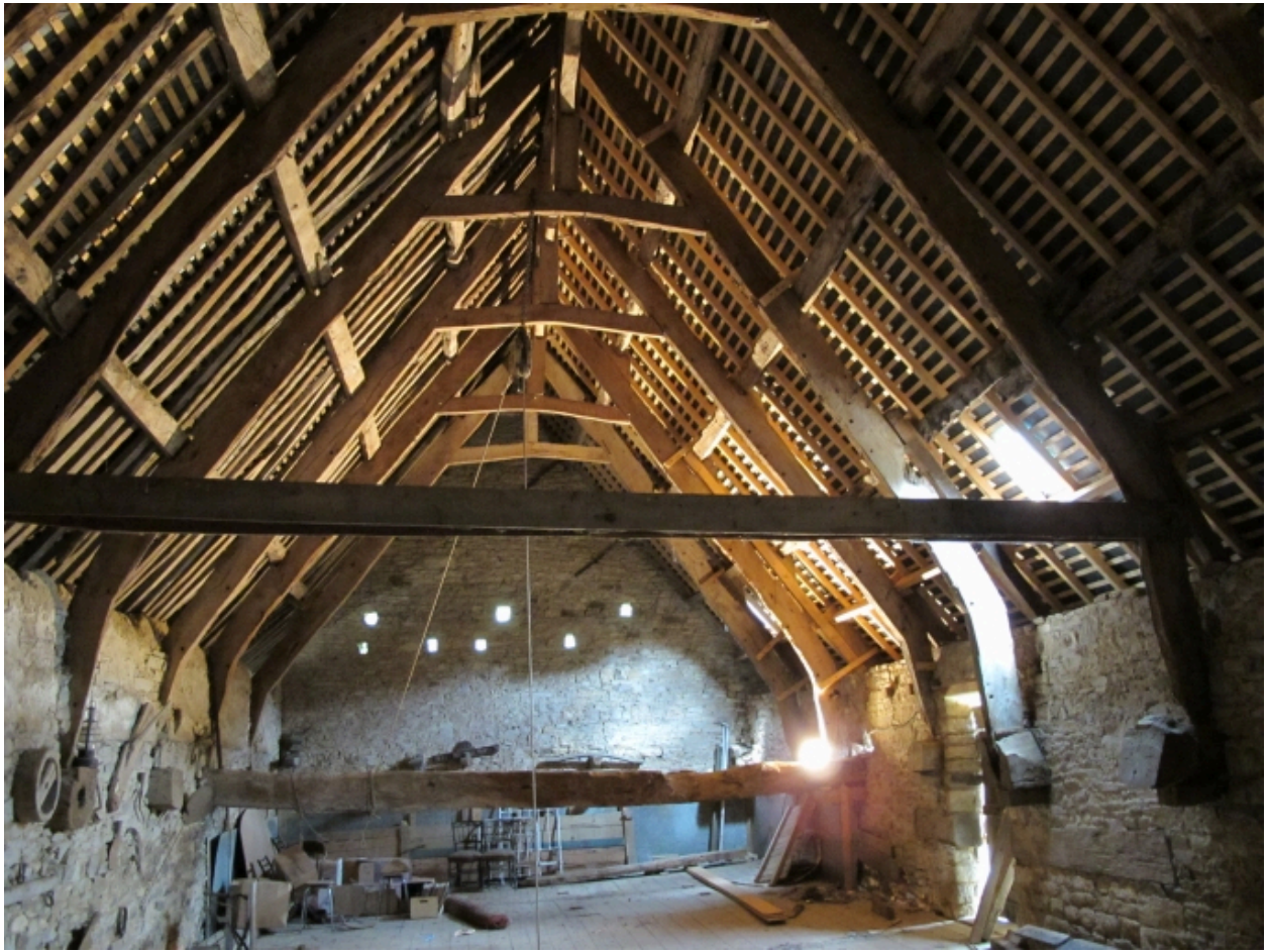
La grange, vue intérieure de la charpente
