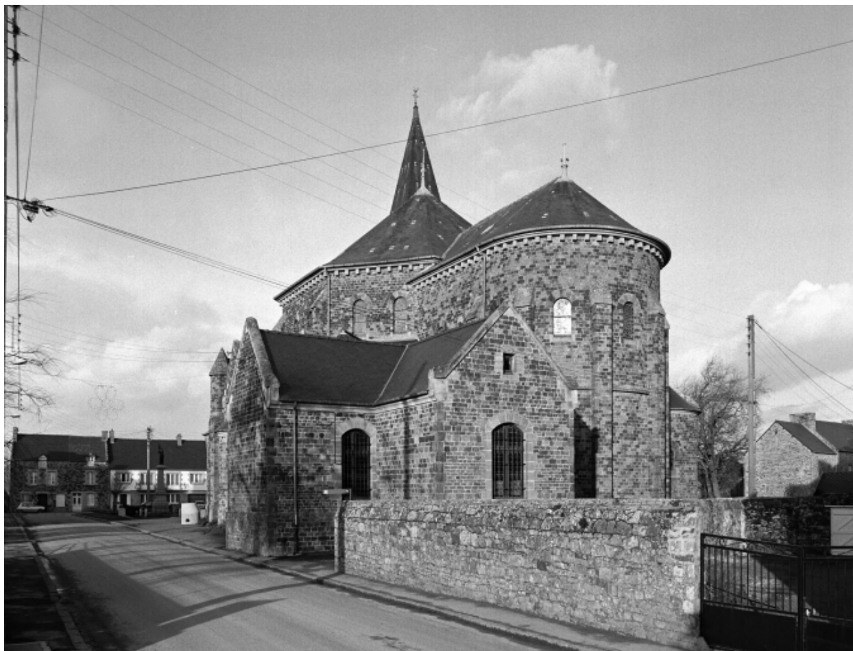
Elévation sud : vue générale
