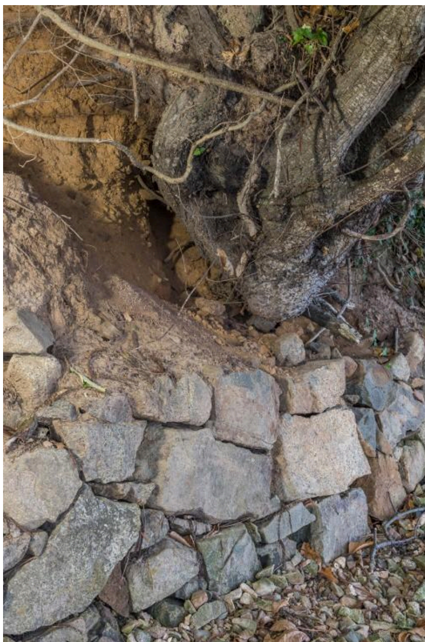
Mur de soutènement surmonté de terre limoneuse marquée par l'érosion marine et d'un arbre, au niveau de la baie de l'Enfer
