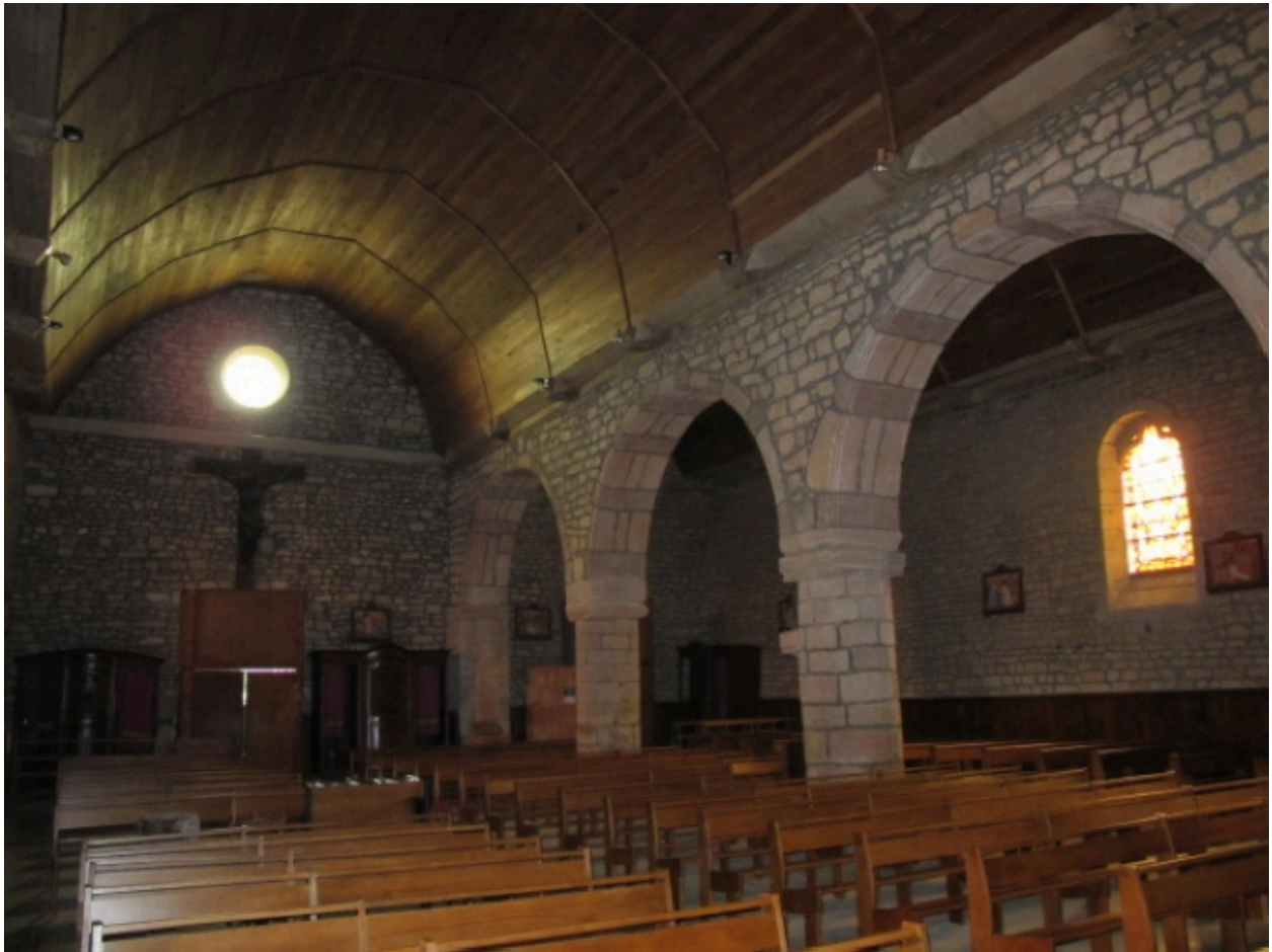
Vue générale depuis le chœur
