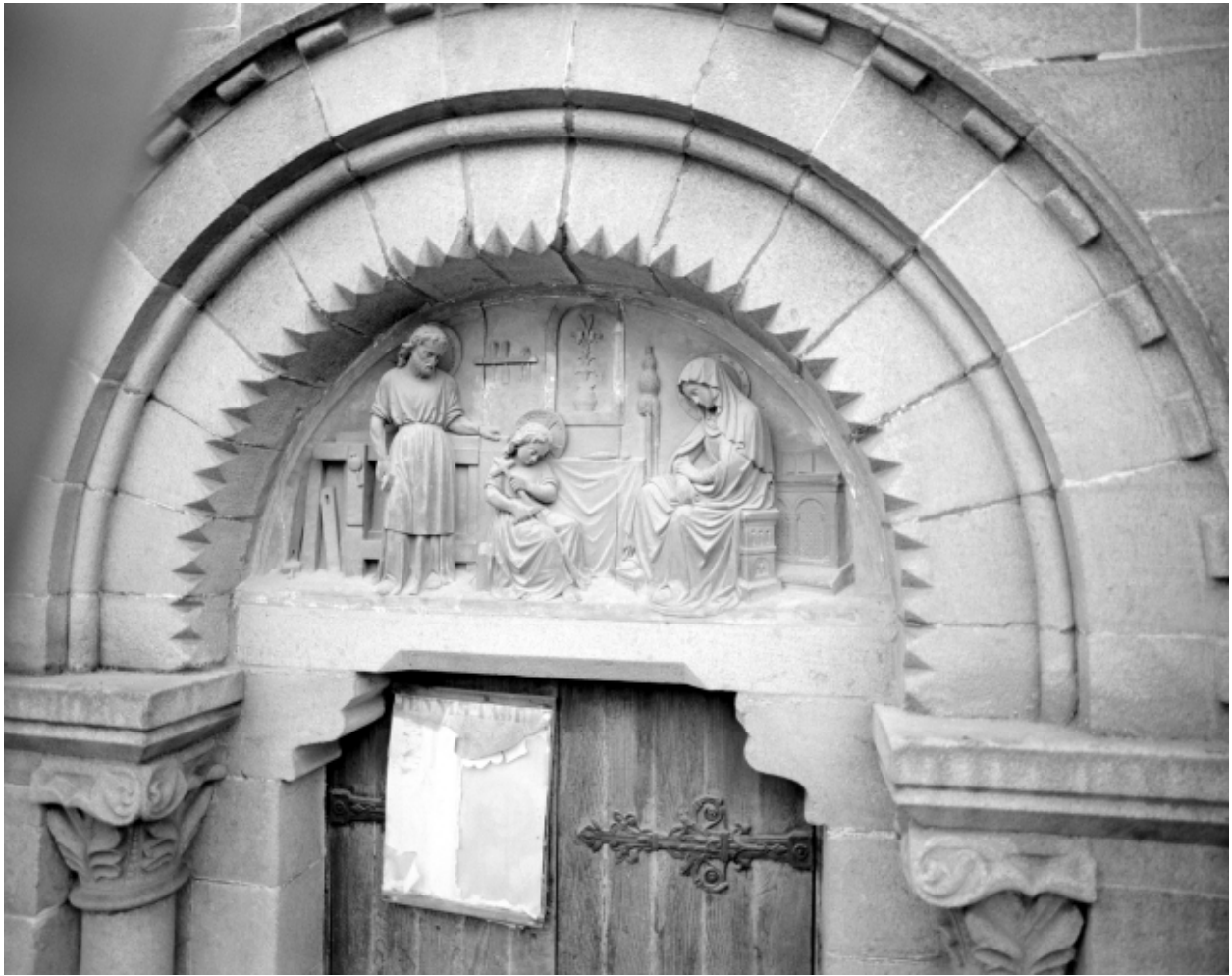
Elévation Ouest, porte : détail du tympan
