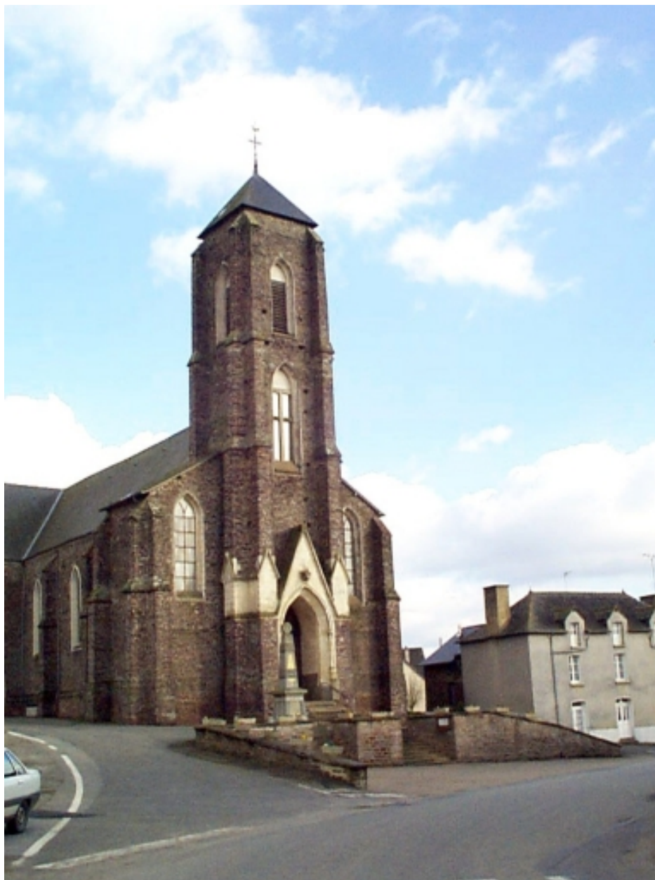
Le clocher : vue générale nord-ouest
