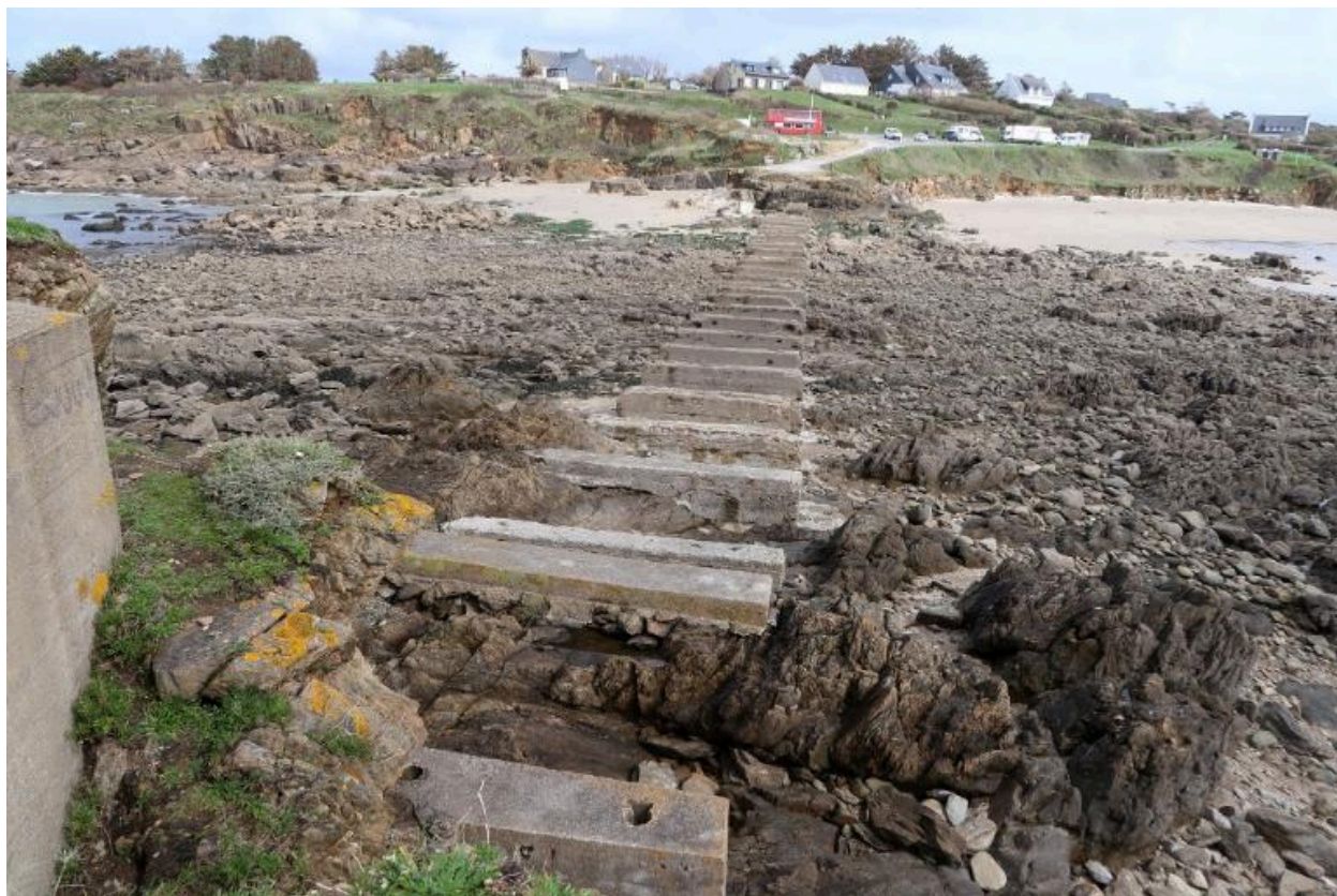
Vue des vestiges de la passerelle
