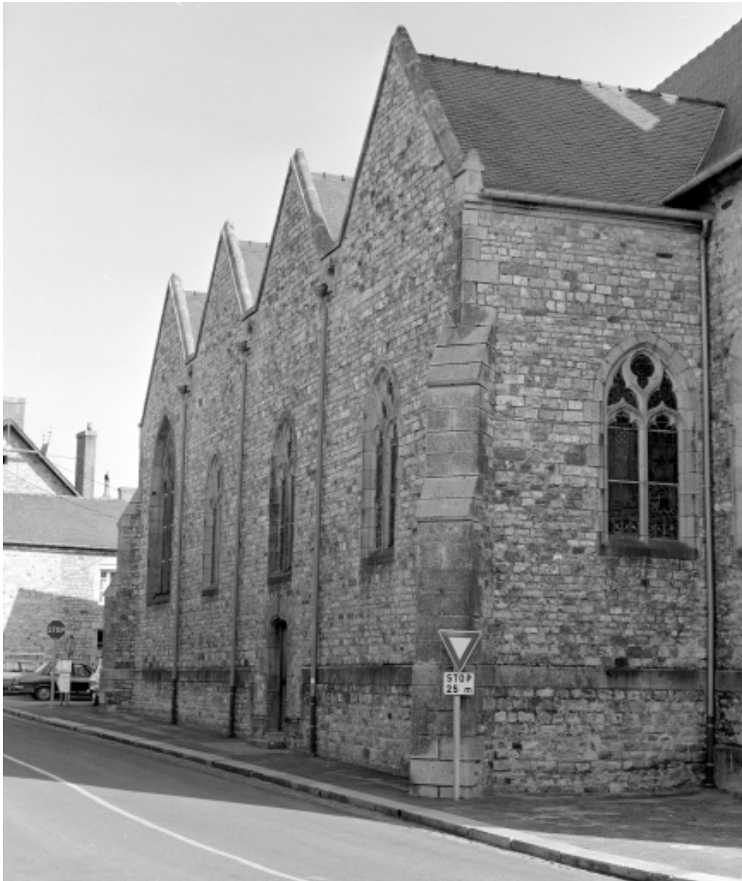
Vue générale nord-ouest, pignon de l'élévation nord.
