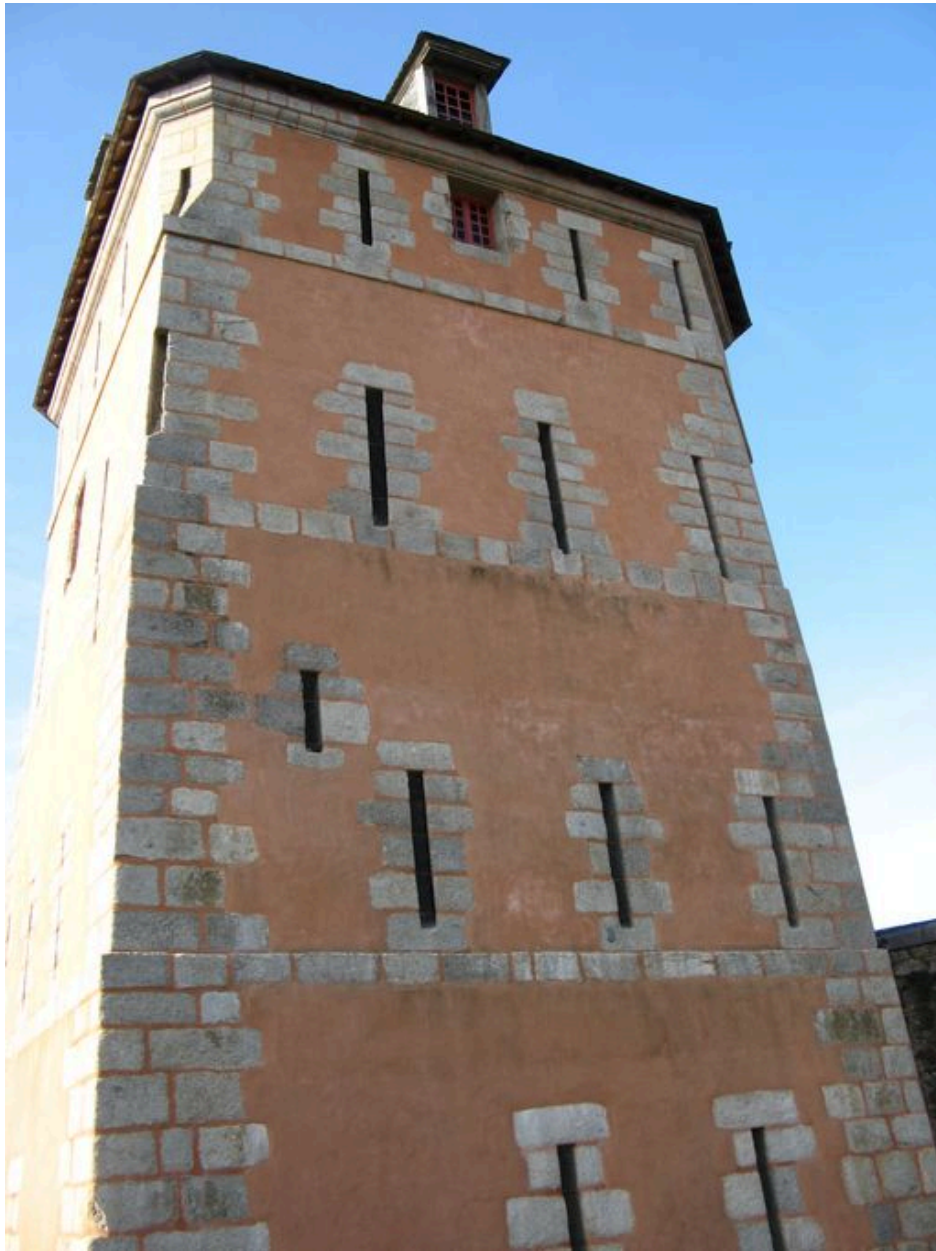
Face est de la Tour Vauban
