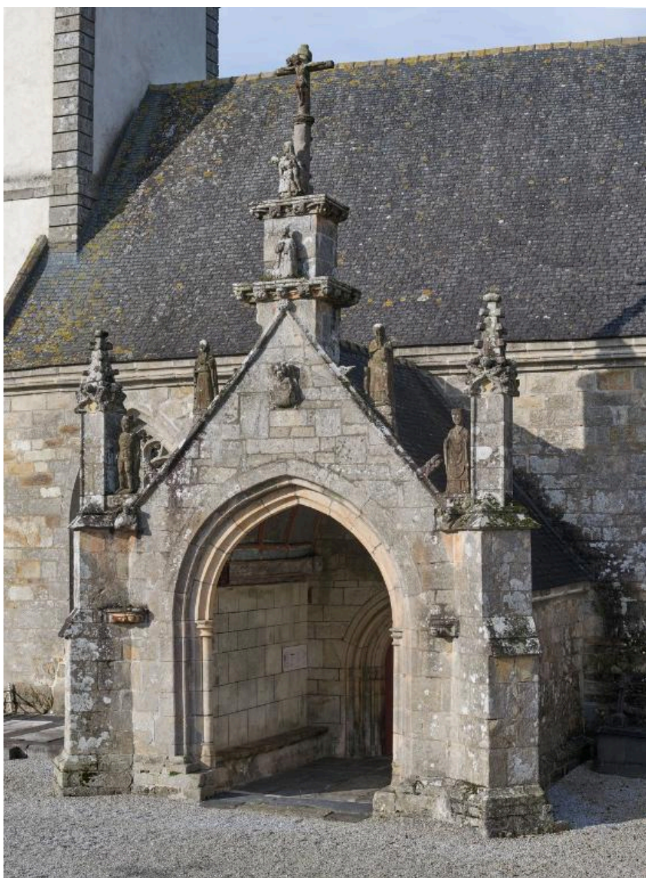
Vue générale du porche sud
