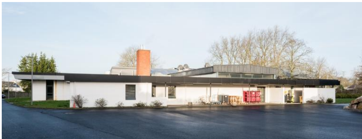
Façade sud-est du service de restauration. Alain Letenneur, architecte, 2006.
