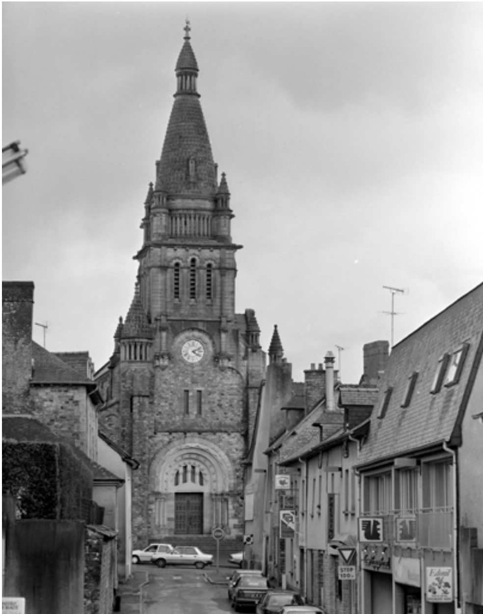
Elévation nord, partie ouest : vue générale
