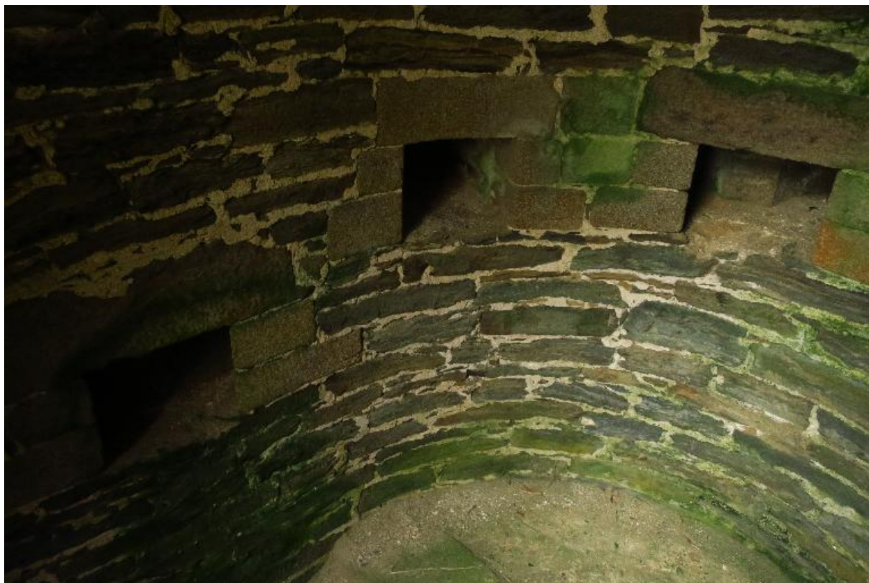
Le Palais, enceinte urbaine, réduit H, escalier de droite, détail.
