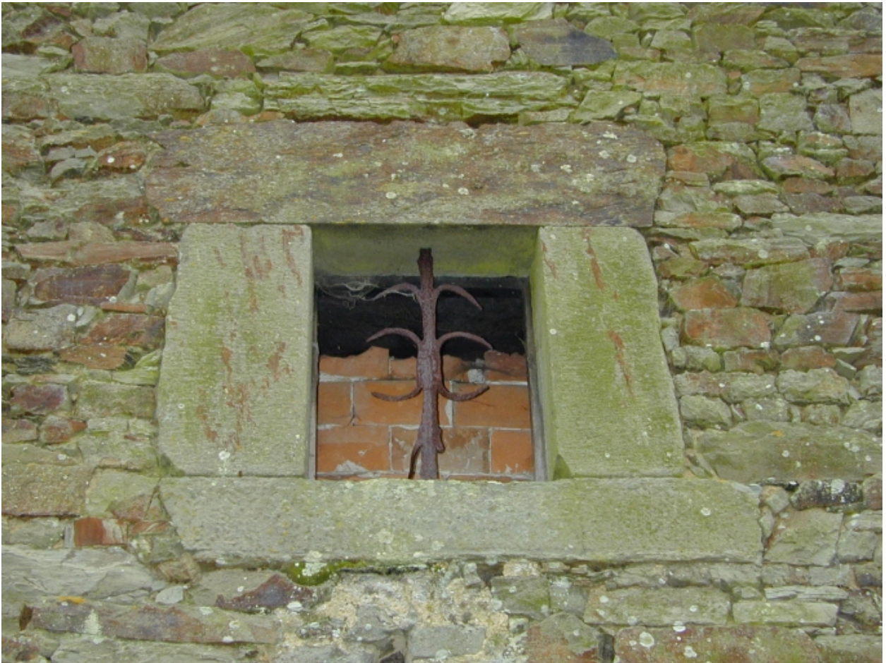
Communs, façade postérieure, jour muni d'une grille : détail
