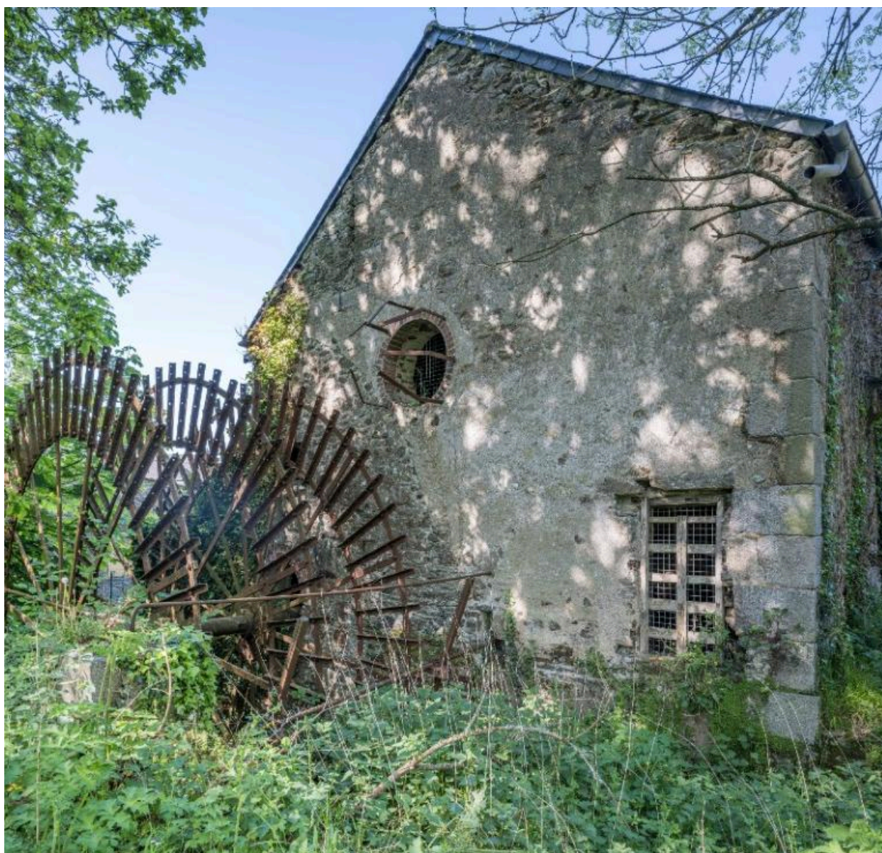
Bâtiment principal. Pignon ouest avec trou d'aération et roue métallique
