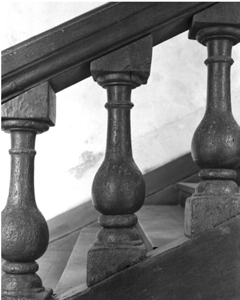
Ancien bâtiment claustral ; vue intérieure : escalier, balustres
