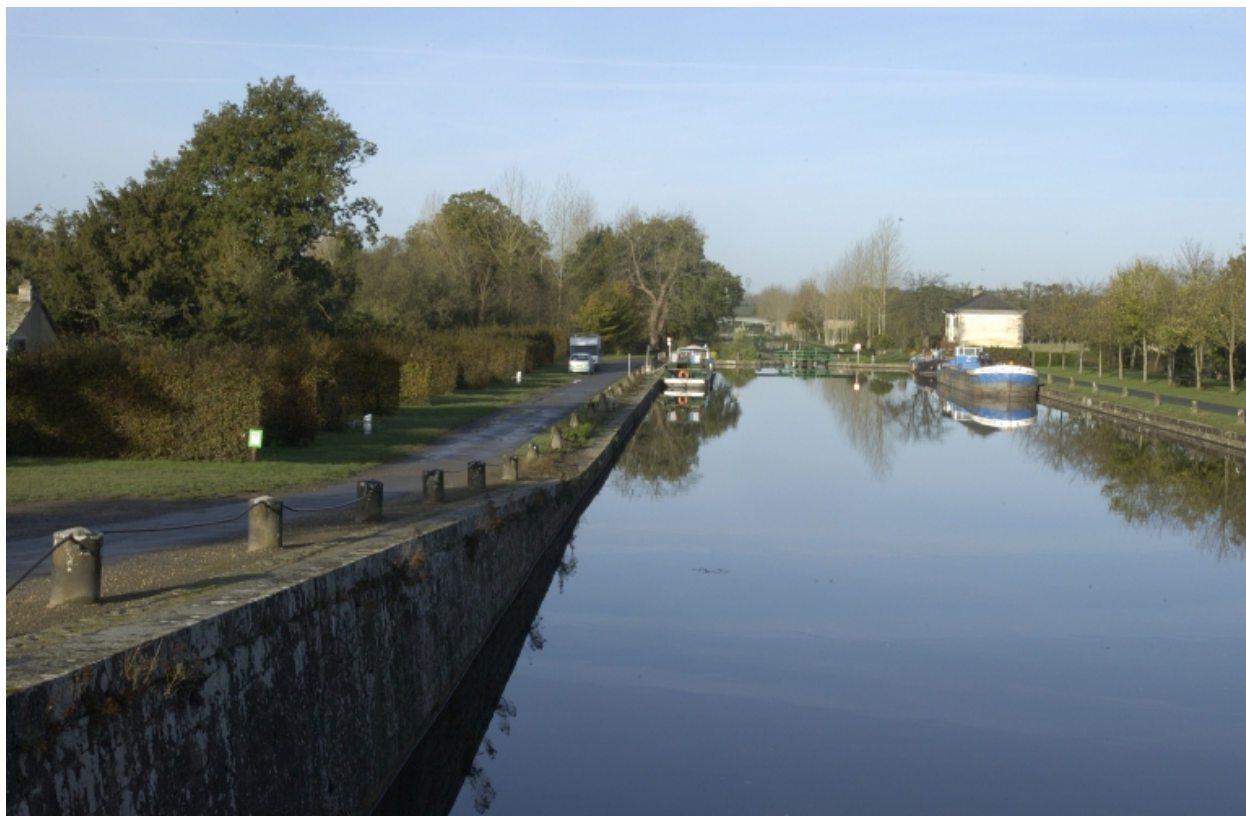
Vue est du canal depuis la Madeleine
