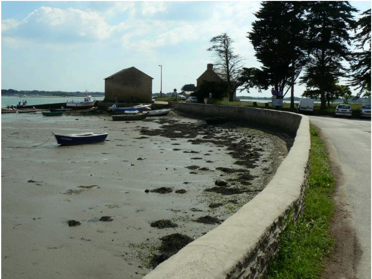
Digue-route du Passage Saint-Armel
