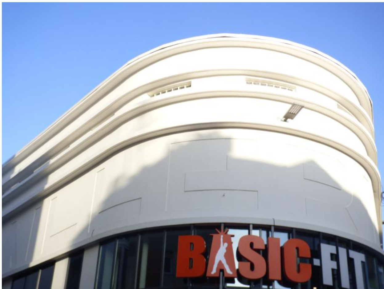
Vue de détail sur le quintuple bandeau et l'ancienne enseigne
