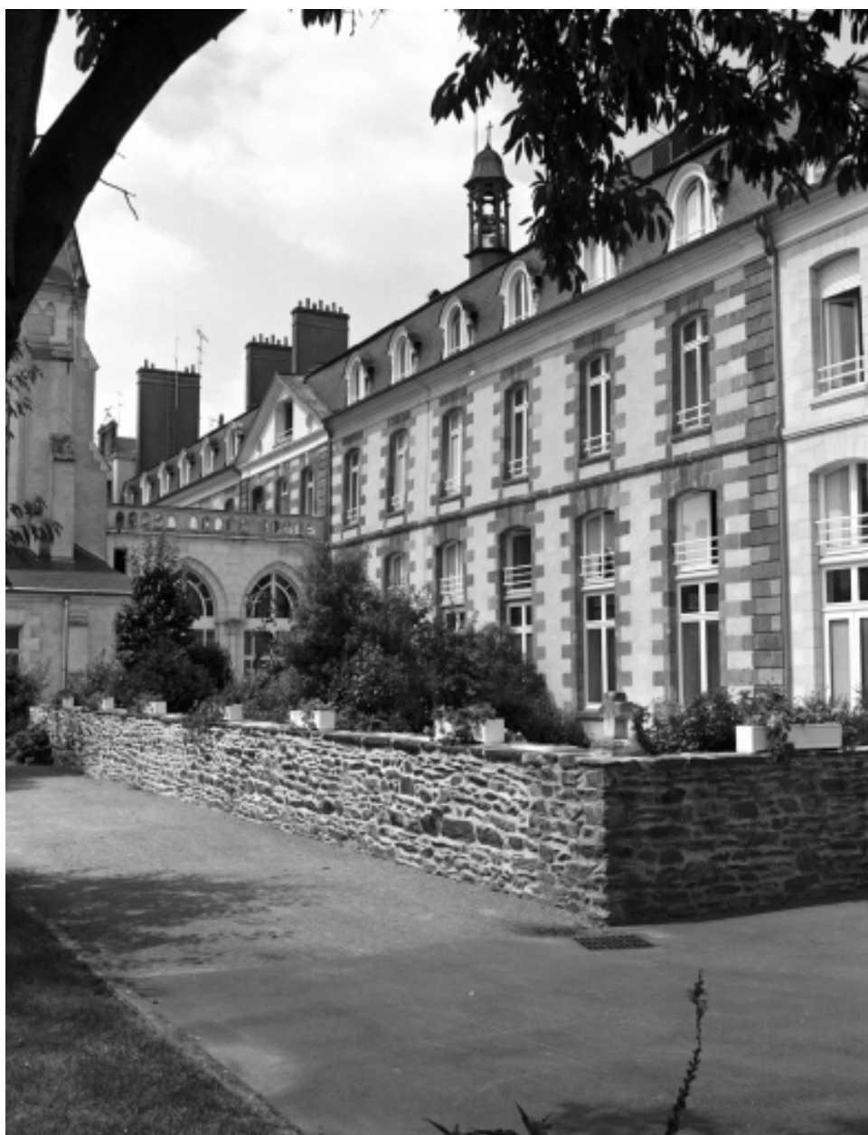
Bâtiment raccord vers la chapelle.
