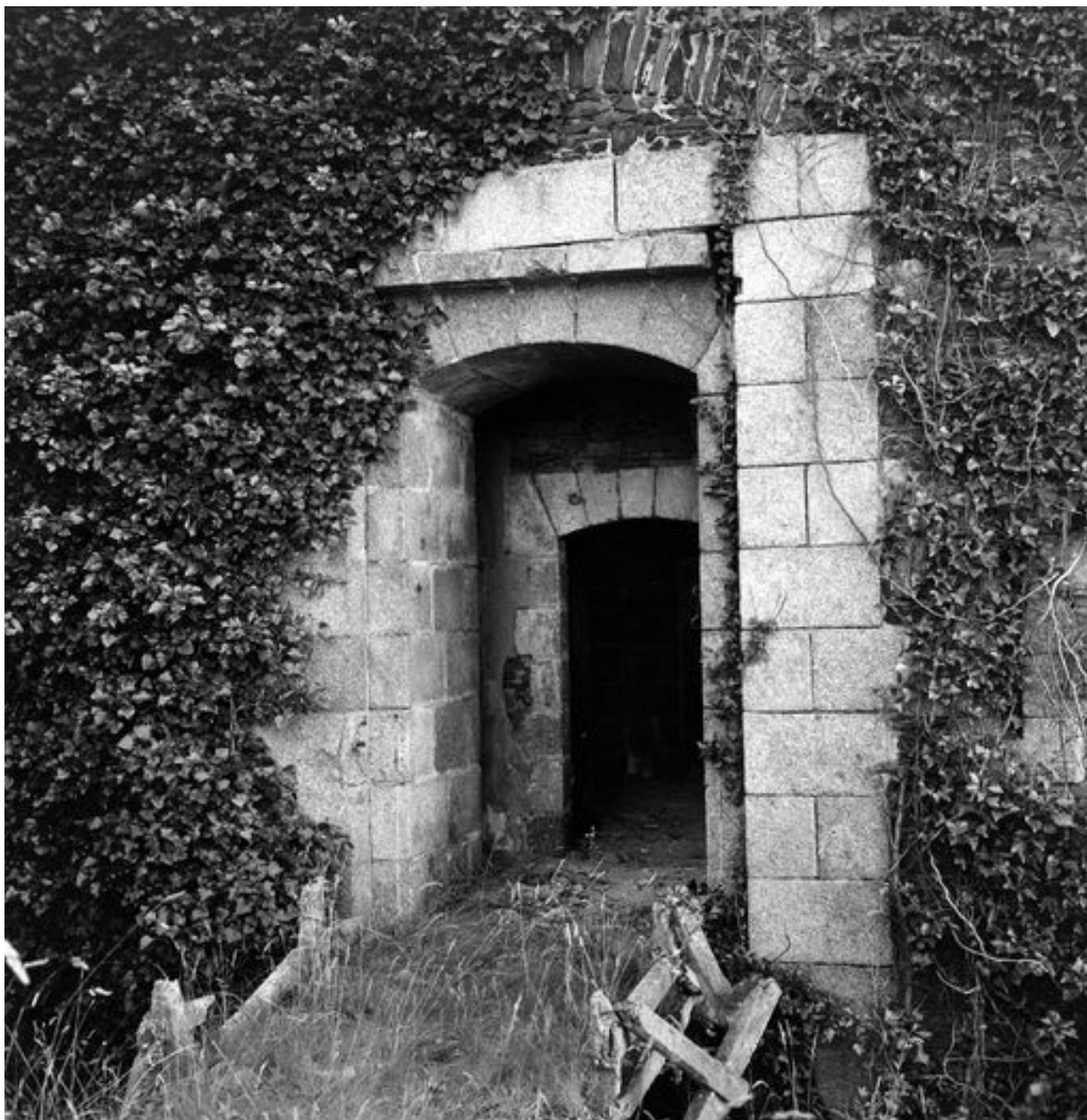
Vue de la caserne défensive Robert en 1969 : entrée
