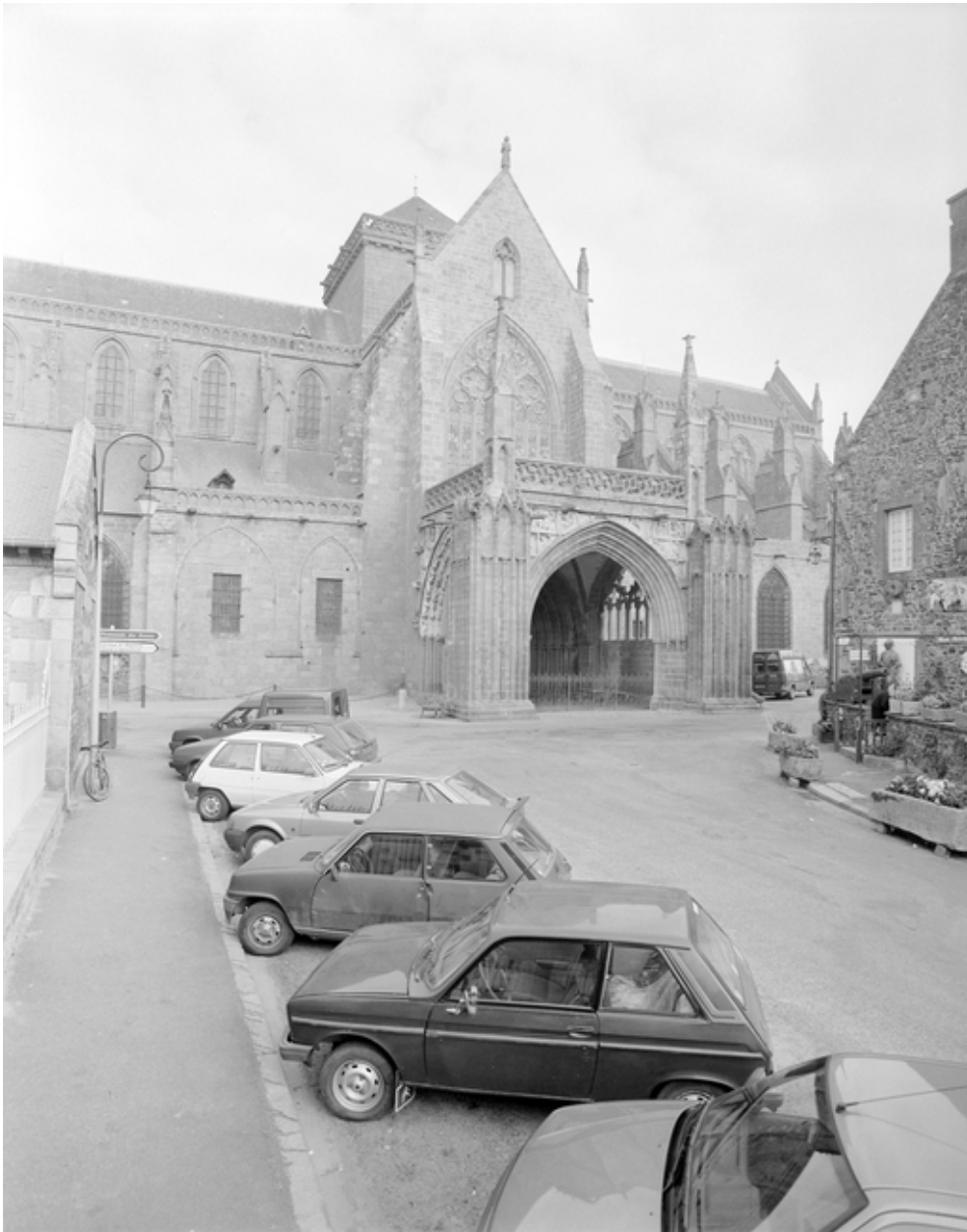
Elévation sud : grand porche
