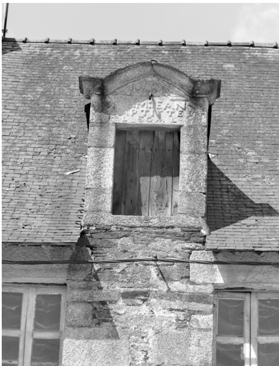
Angle rue de la Fontaine et 2 rue Général Kenivet, lucarne détail.
