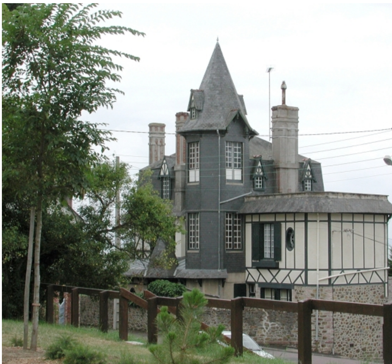
Vue générale de la façade postérieure
