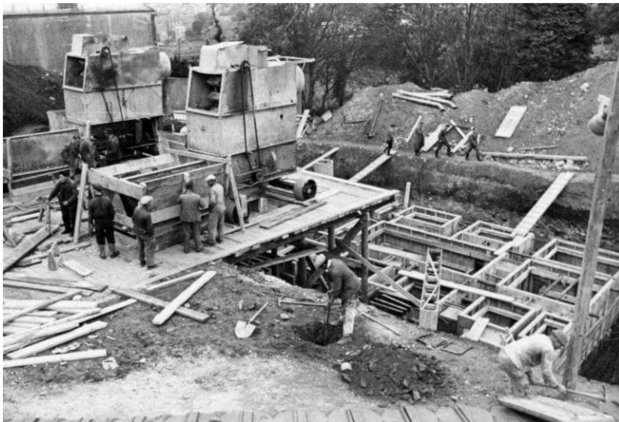
Exemple de chantier de construction d'un bunker à Brest (1 100 m<sup>3</sup>). Au centre, les deux bétonnières Regulus Großmischer (type B, 20 m<sup>3</sup> ou C, 15 m<sup>3</sup> ?) fabriquées par Seelemann & Söhne à Neustadt-Orla sont positionnées pour la coulée du béton
