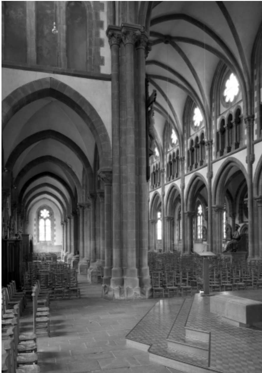
Douarnenez, église du Sacré-Coeur : vue intérieure à partir du transept sud, état en 1984
