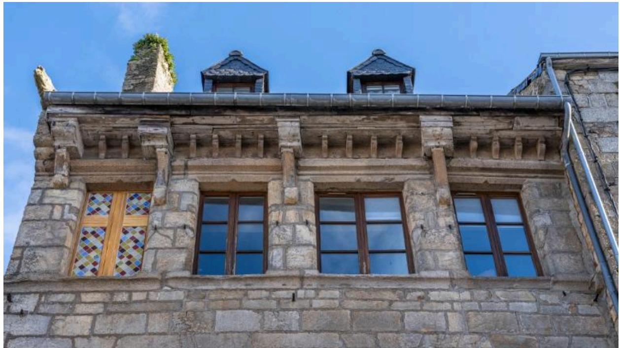
Des aisseliers en bois reposant sur des culots en pierre soutiennent les abouts de poutre sous la toiture.
