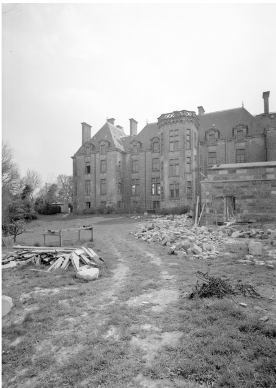
Façade nord, vue générale
