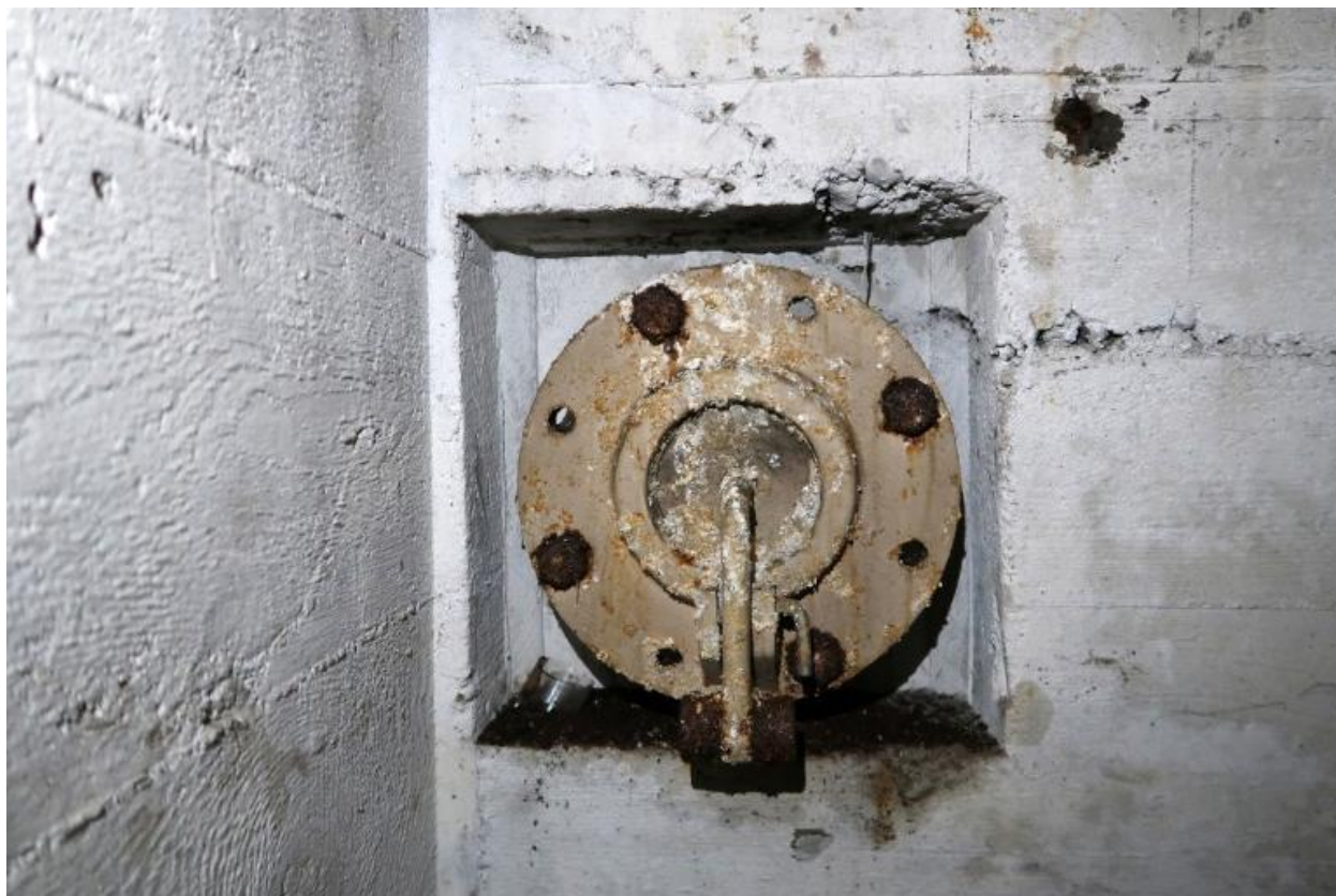
Vue intérieure : petite pièce située au nord-est, bouche de surpression à clapet à contrepoids en aluminium
