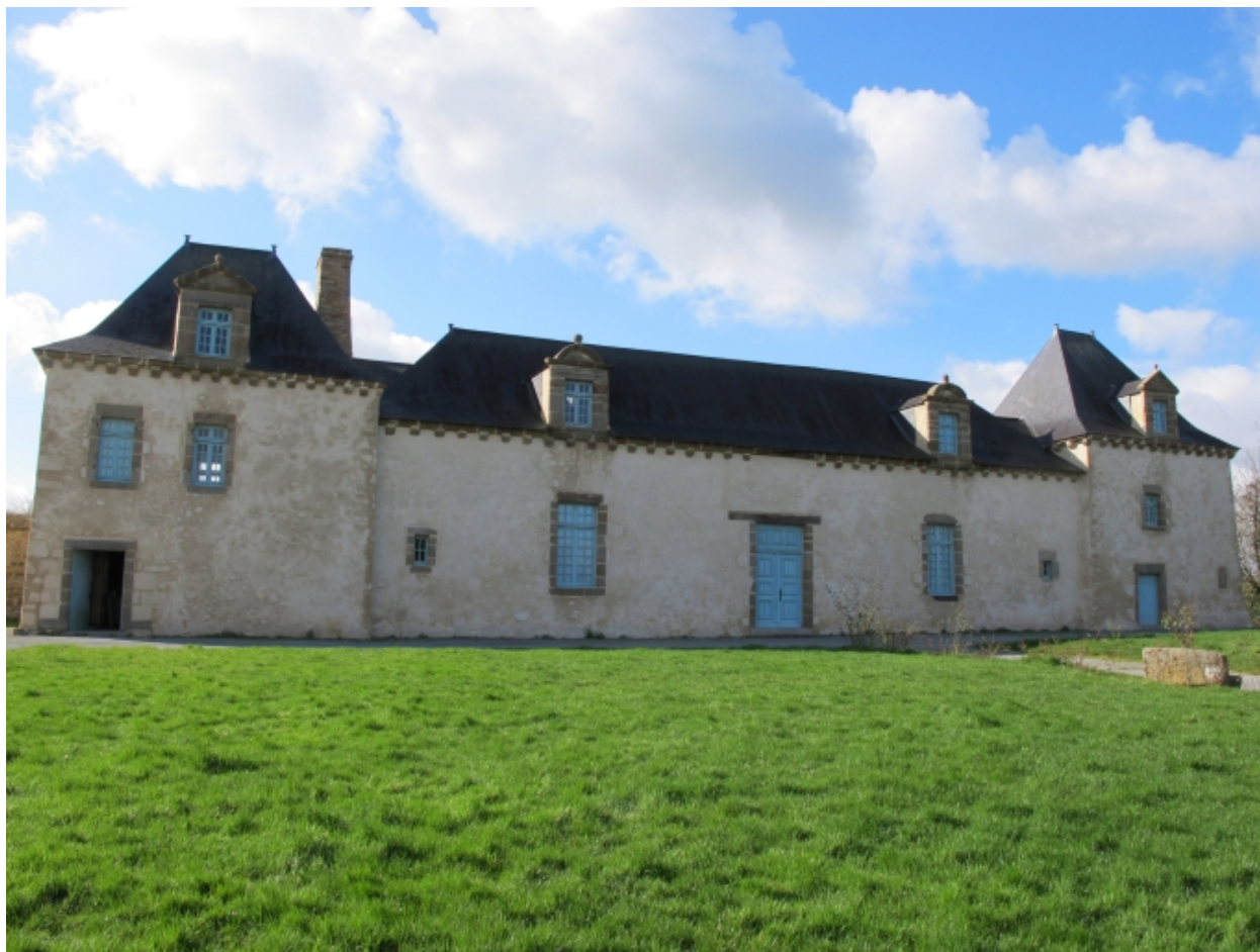
Vue nord du bâtiment sud-ouest
