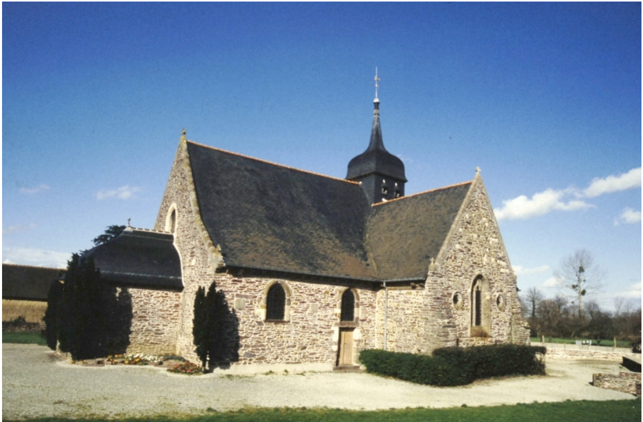
Elévation sud-ouest : vue générale (état en 1994)
