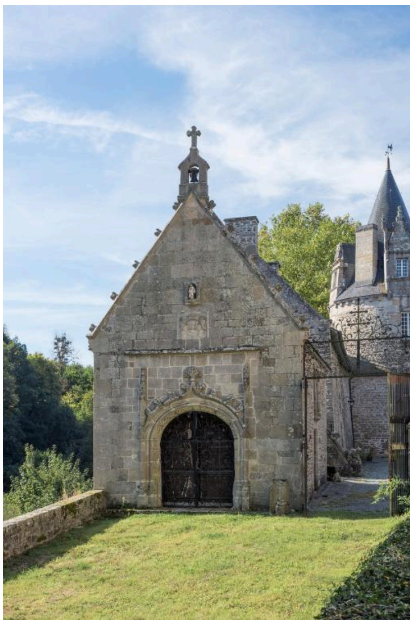
Chapelle : façade nord principale
