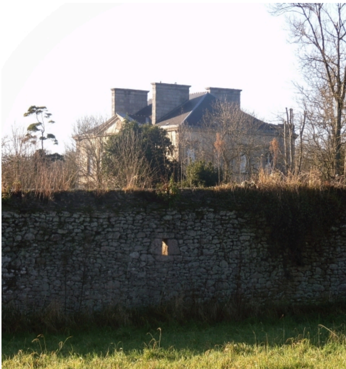
Vue générale (façade postérieure)
