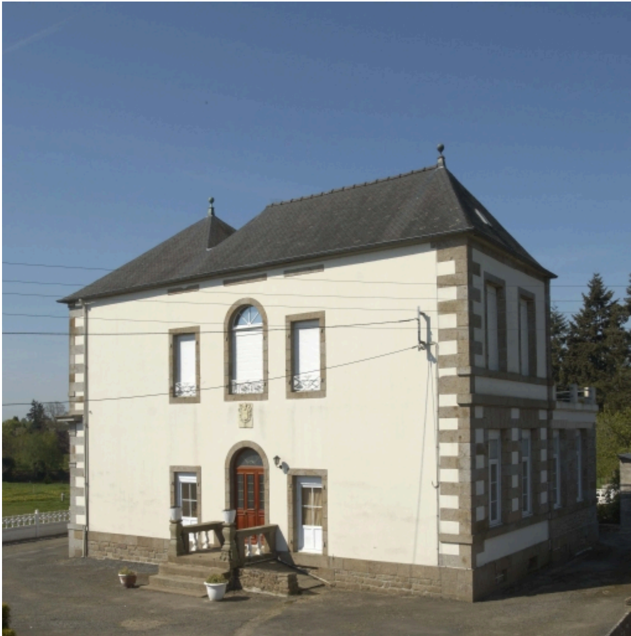
Façade est de l'ancien château.
