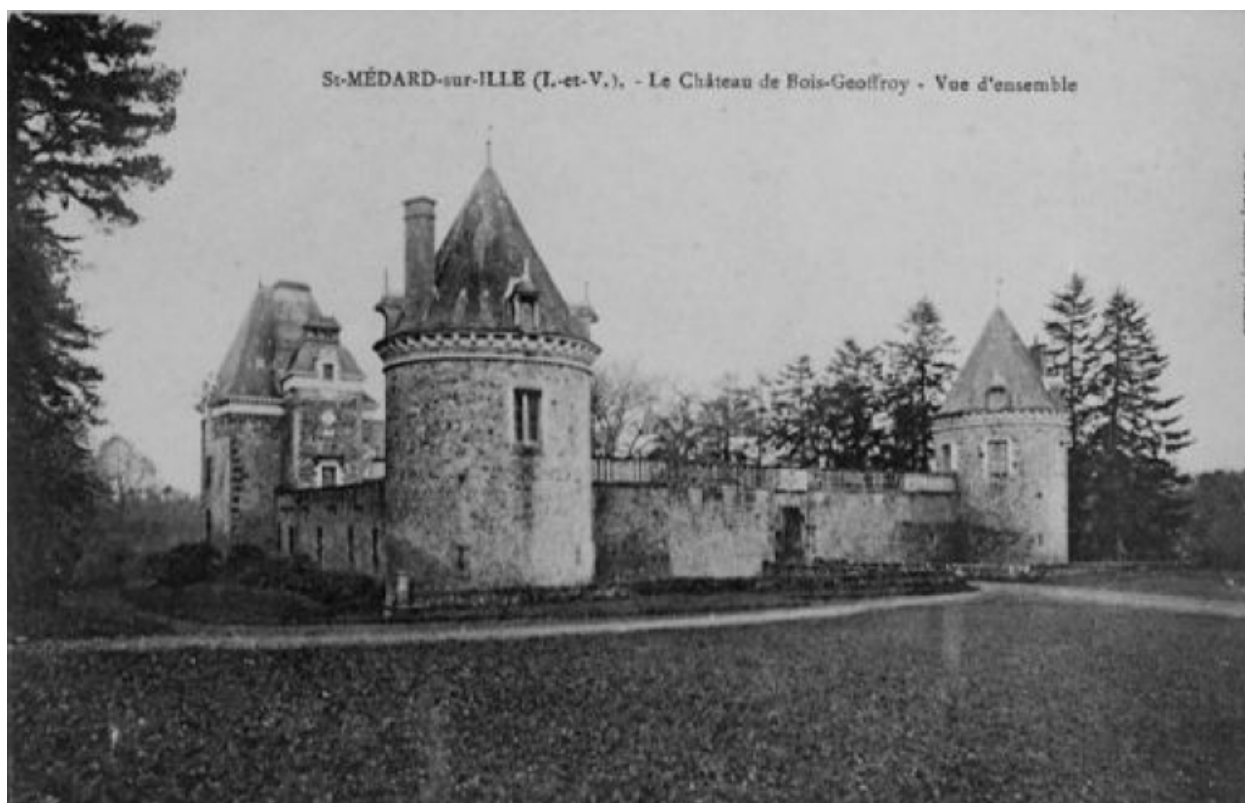
Vue de l'enceinte du château
