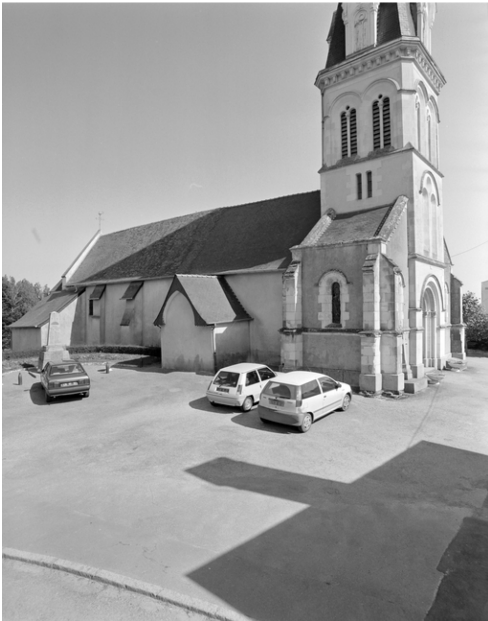
Elévation Nord-Ouest : vue générale
