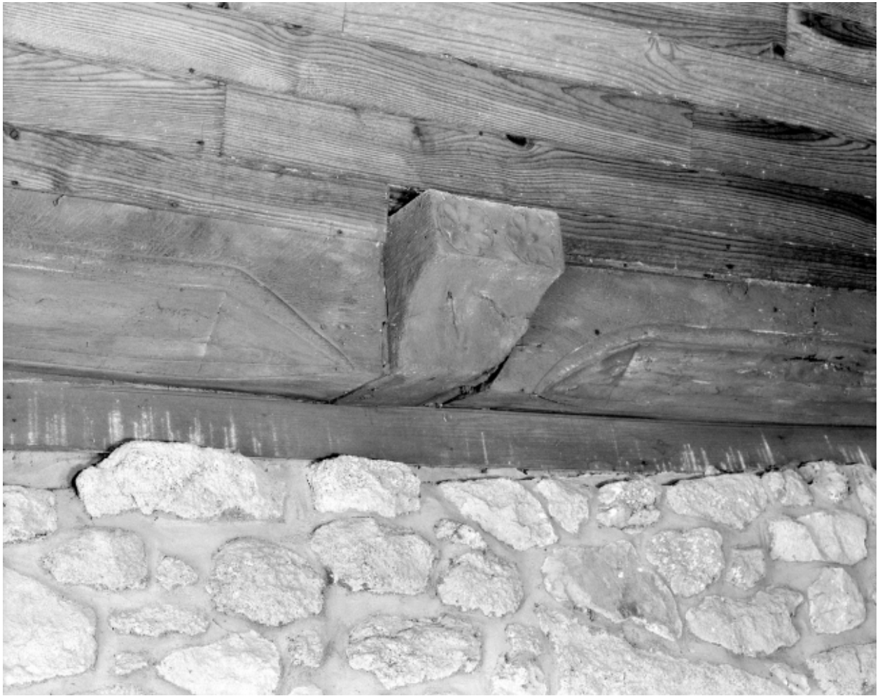
Intérieur : détail de la charpente.
