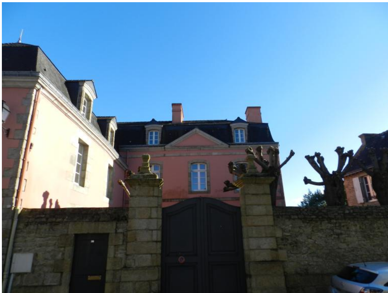
Hôtel de Perrien, portail et façade sur la Grande rue
