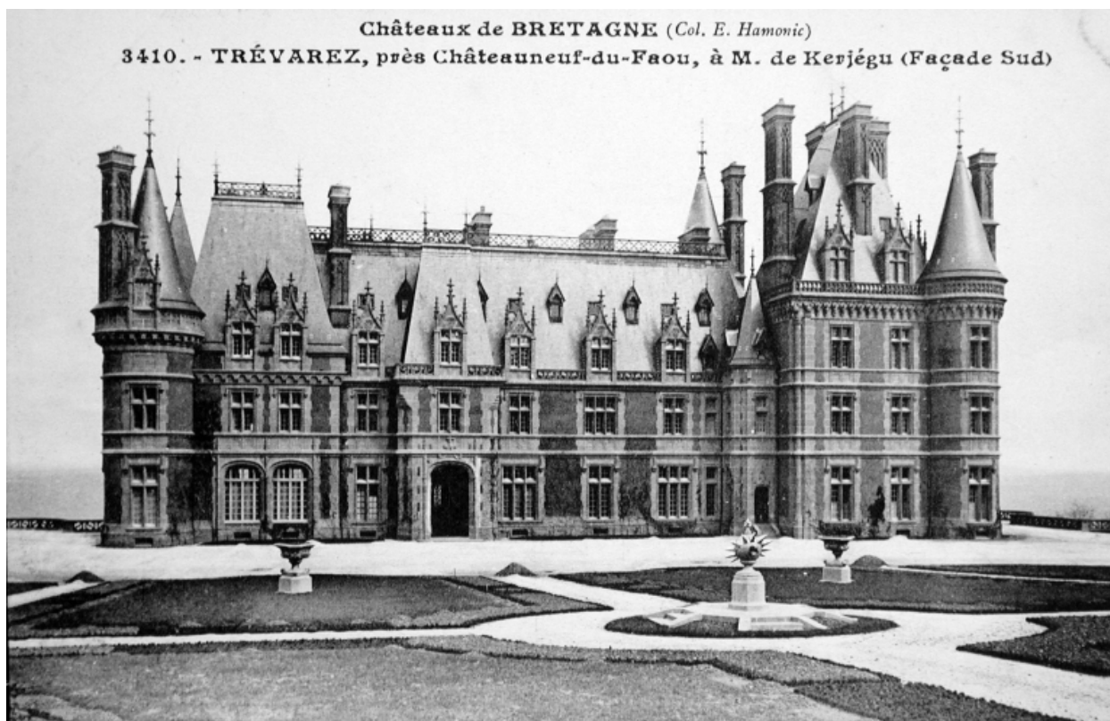
Vue de la façade principale (Archives départementales d'Ille-et-Vilaine, 6 Fi Saint-Goazec)
