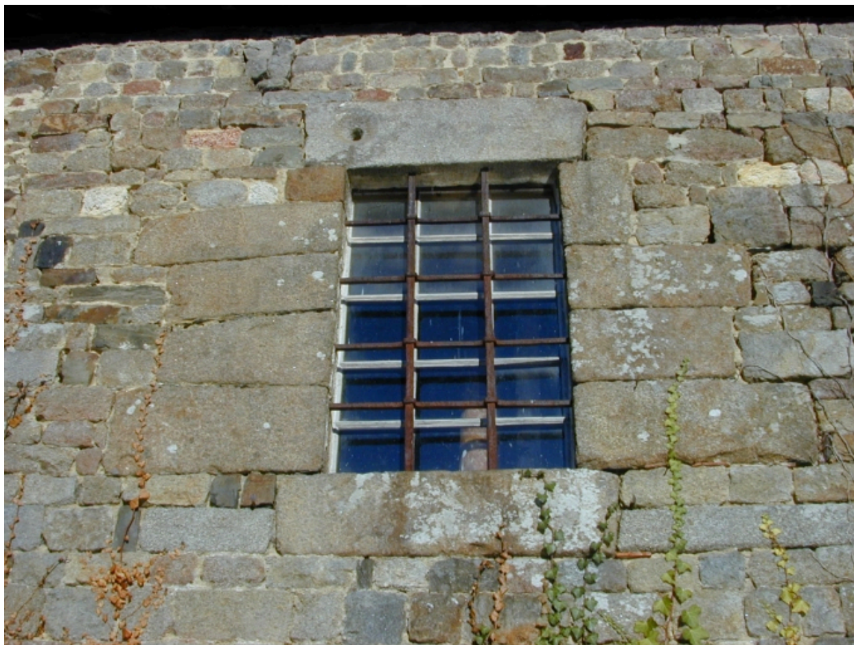
Longère sud, baie du choeur : vue générale
