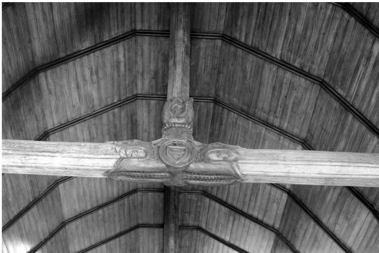
Intérieur, nef, charpente, retombée du poinçon : vue générale.
