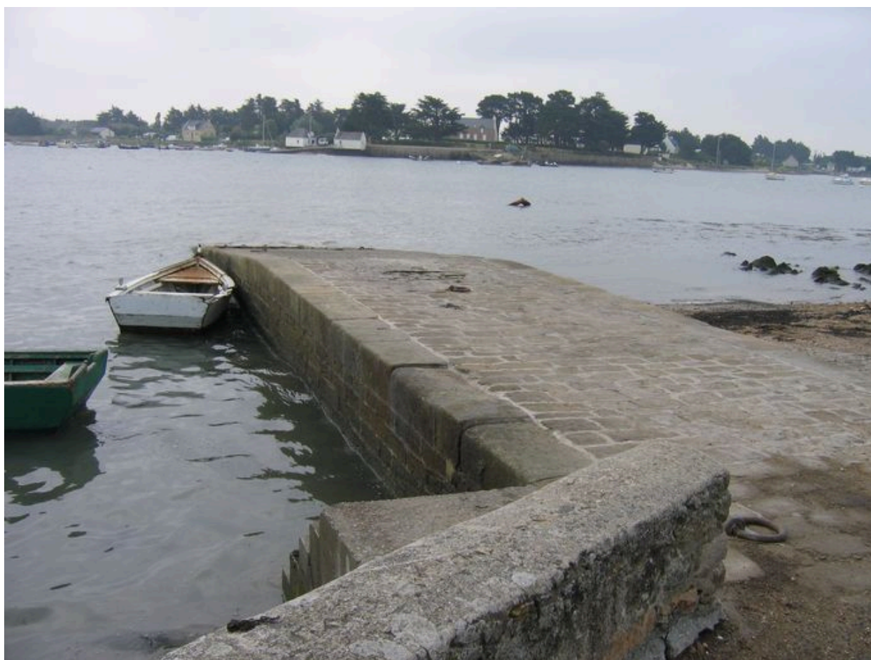
Transit terre/mer : cale de passage de Saint-Armel (Séné)
