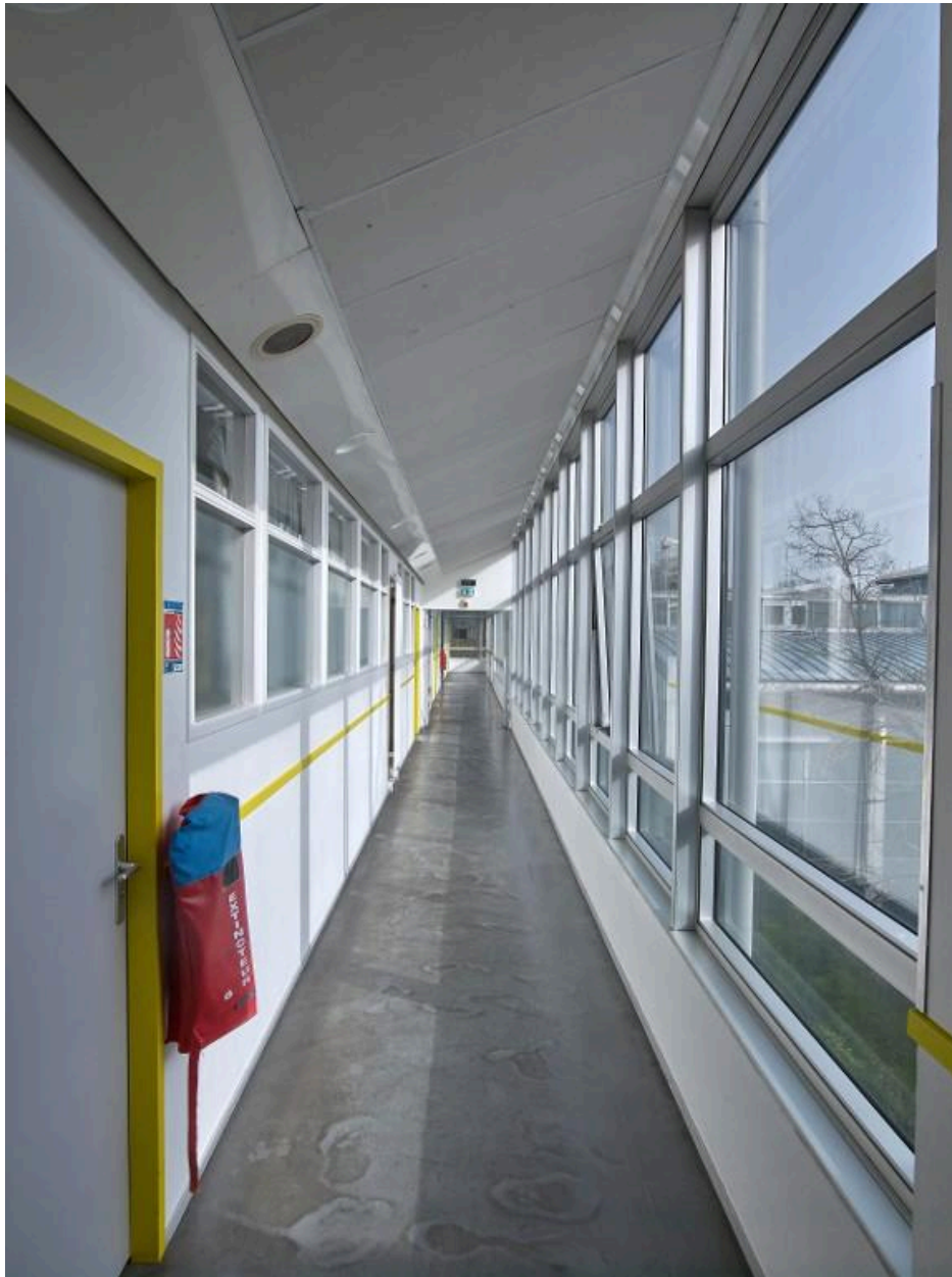
Bâtiment principal. Couloir latéral desservant les classes. Joël Y. Gautier, architecte, 1992.
