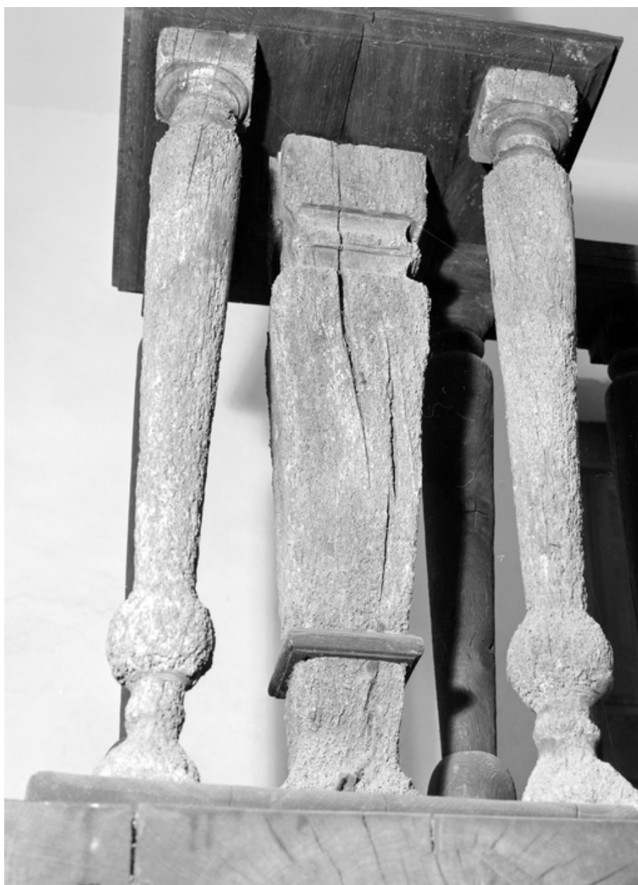
Rampe d'escaliers remployés.
