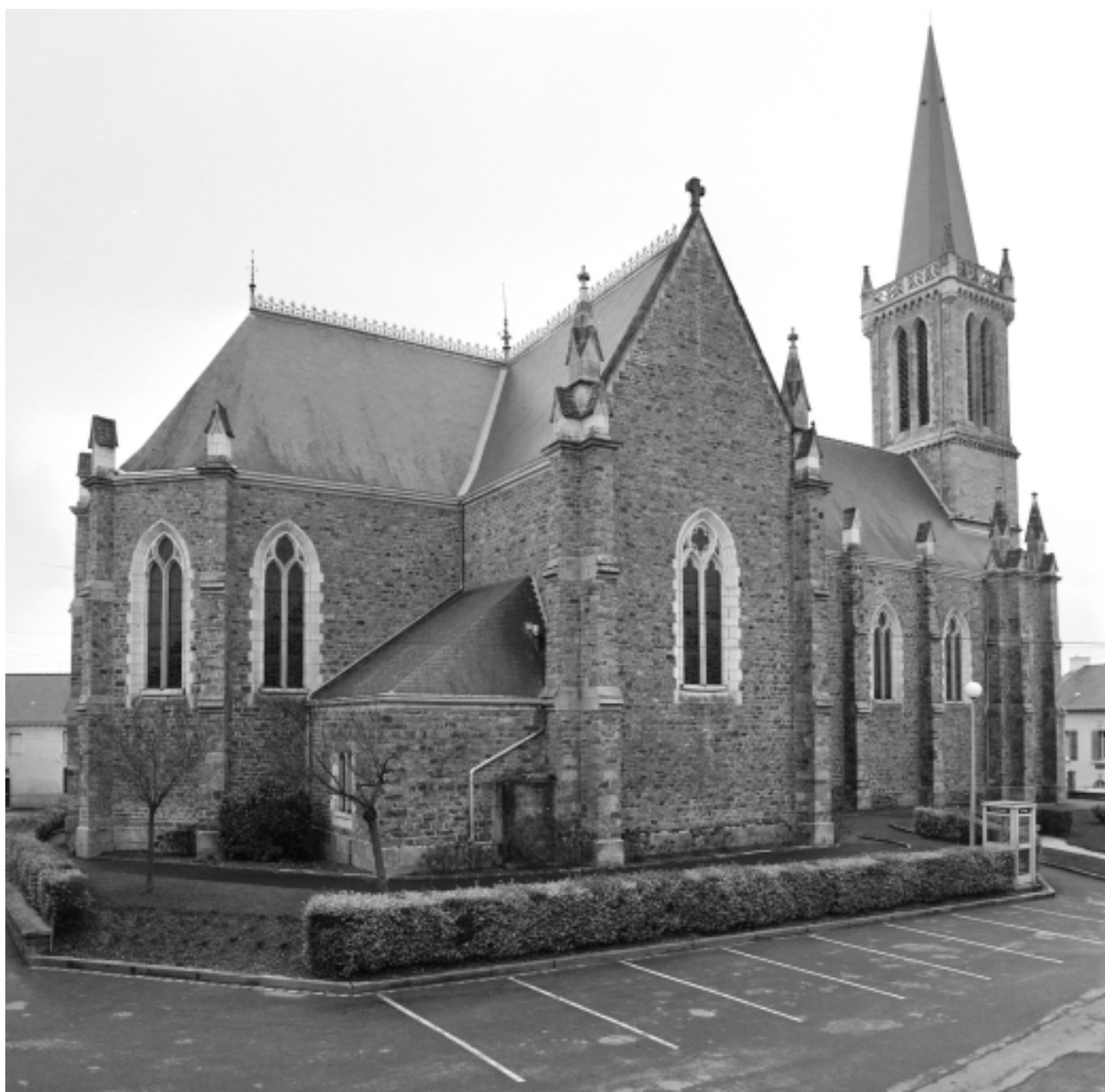
Elévation nord-est : vue générale
