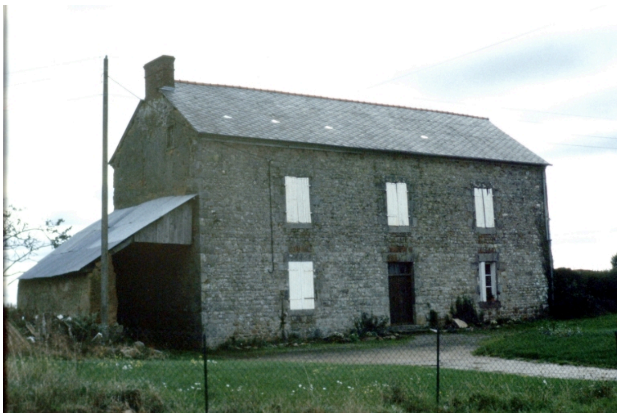
Le bourg, maison : vue générale
