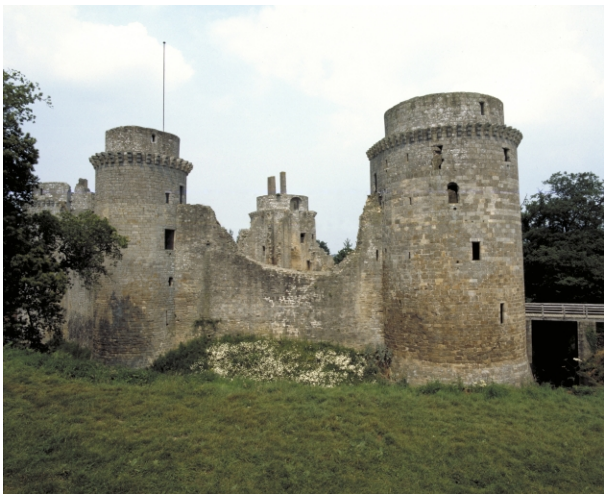
vue générale nord
