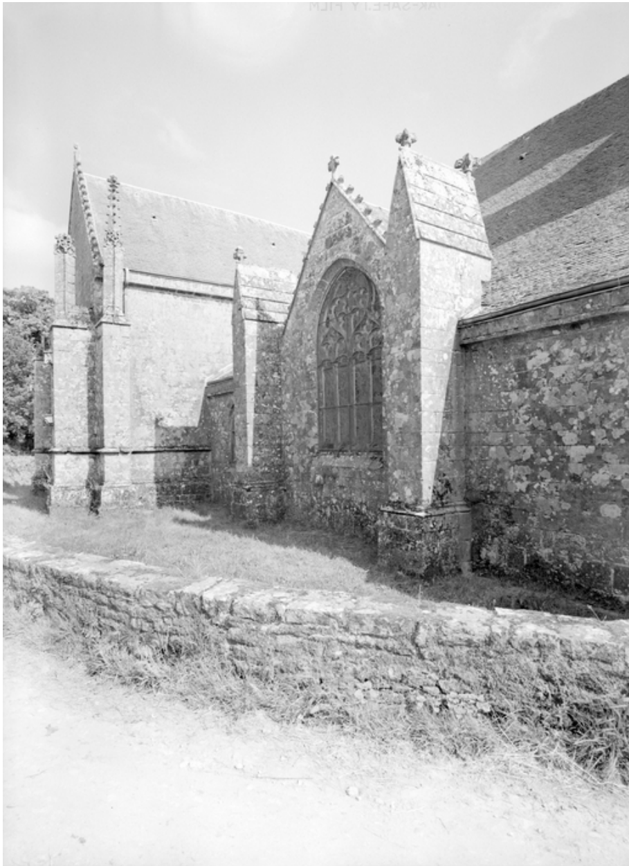
Façade nord, partie centrale.
