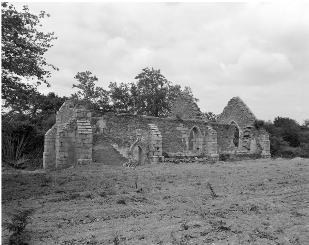
Vue générale de la façade sud prise du sud ouest
